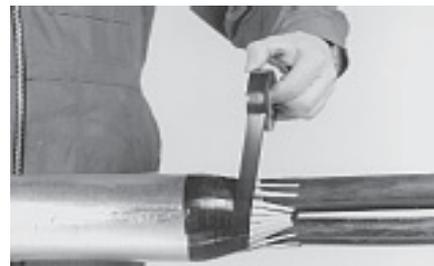
Обожмите концы каркаса до нужного размера и закрепите термостойкой лентой. На кабель лента должна заходить не более 5 мм.
