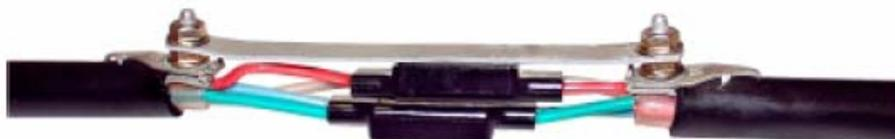
Соедините жилы кабеля соединителем U1B и установите шину заземления
