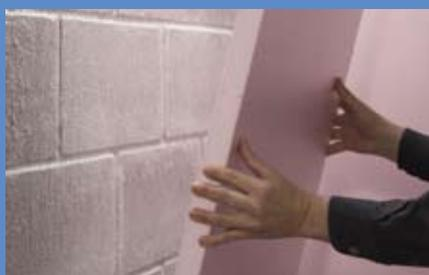
Крепление теплоизоляционного материала на контактный адгезив
