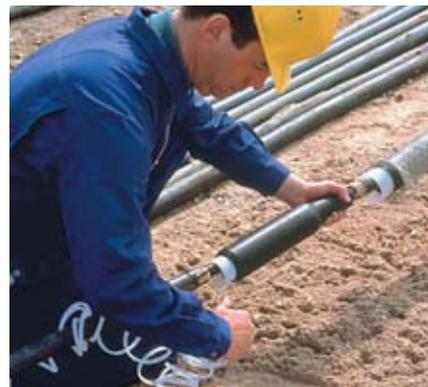
Соединение электрических кабелей муфтой холодной усадки
