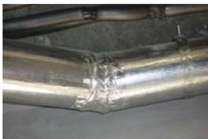
Защита соединительного шва на металлическом воздуховоде
