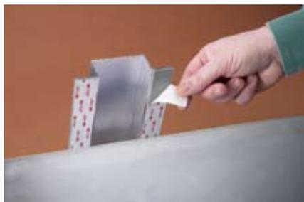
Крепление ребра жесткости на двустороннюю клейкую ленту VHB™
