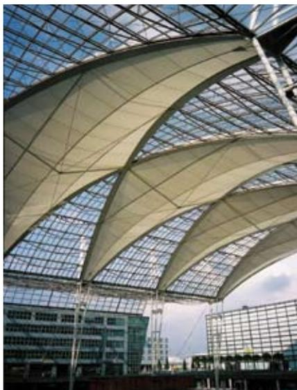
Аэропорт в г. Мюнхен — остекление крыши с помощью архитектурных мембран
