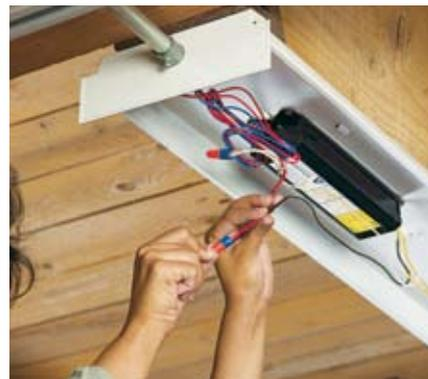
Соединение проводов с помощью колпачковых соединителей Scotchlok™
