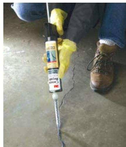
Ремонт трещины в бетонном полу с помощью состава Concrete Repair™
