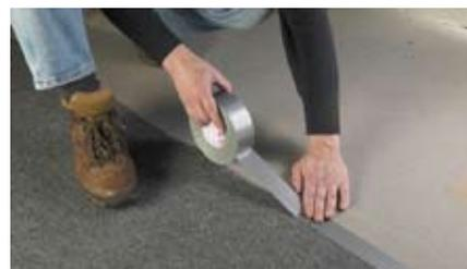
Крепление напольного покрытия с помощью виниловой ленты
